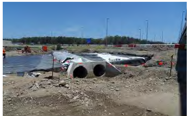
(d) Protective membrane installation
